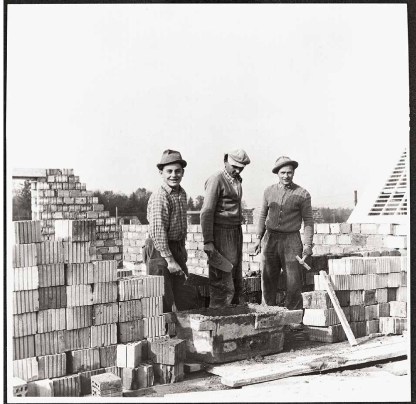
Leopold Untermayer, links und rechts davon die Brüder Franz und Heinz Söllner bei der Baustelle Unterer Porst in Dornbirn, im Jahr 1957. © Stadtarchiv Dornbirn, Bestand Reiter Johanna
