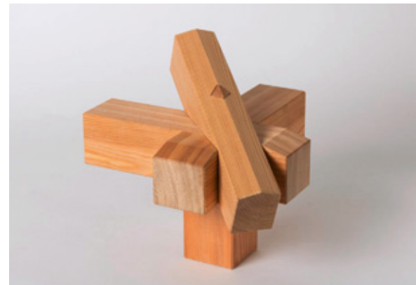
Stufenzapfen für Walmdach, Foto: ETH Material Hub
